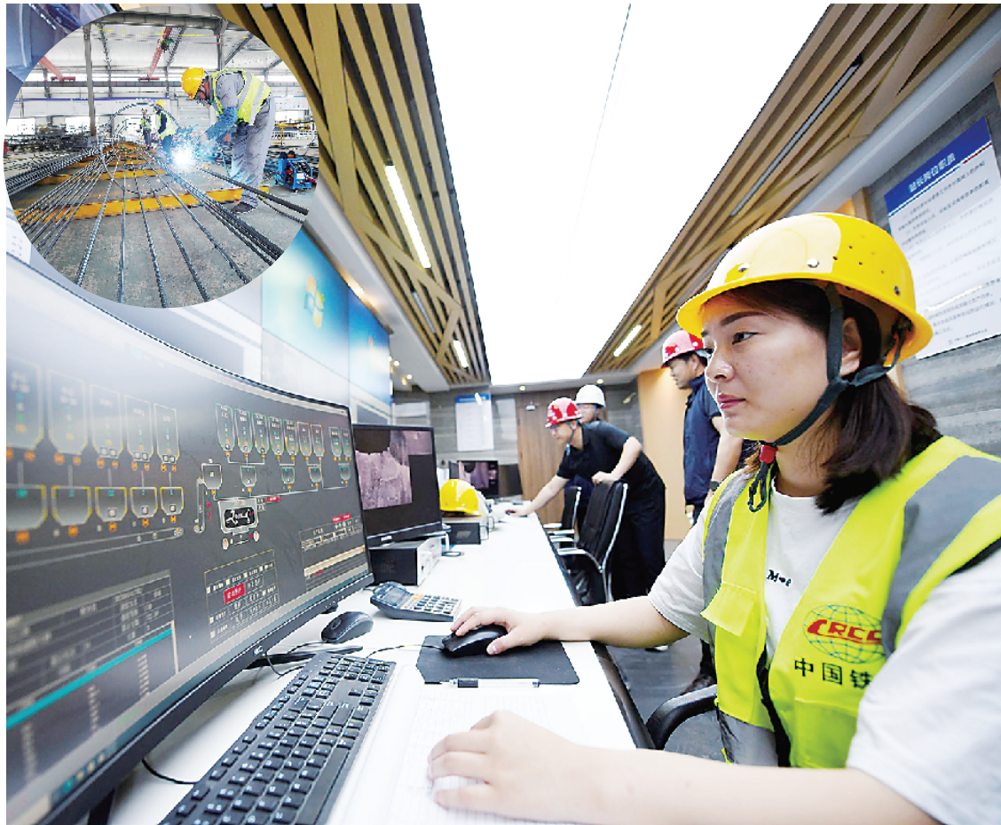
4 月 22 日，在跨宁洛高速特大桥施工项目钢筋加工车间，记者看到工人（左上）在焊接桩基的钢筋笼。在不远处的拌和站信息化智能中心操作室里，技术人员正通过信息化管理系统，完成混凝土的自动化生产。 记者 梁照曾 摄
